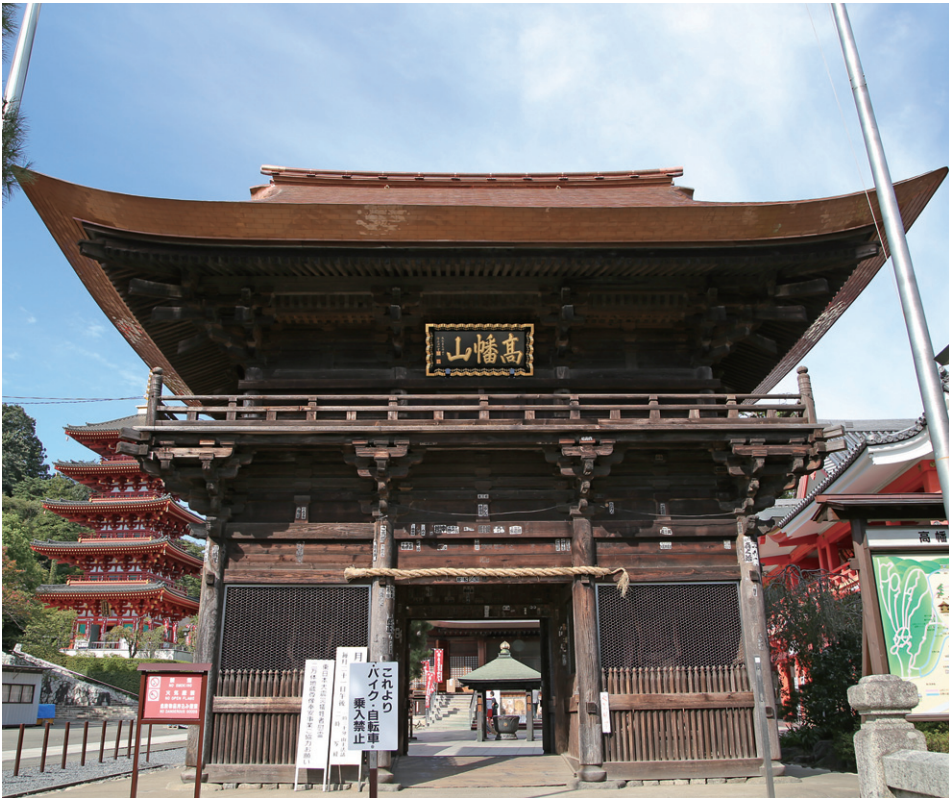
保存修復作業完了の仁王門（関連記事3頁・13頁参照）
