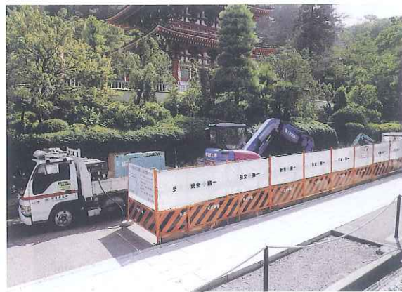
塔院北側入口スロープ設置工事 (9月中の完成予定です)
