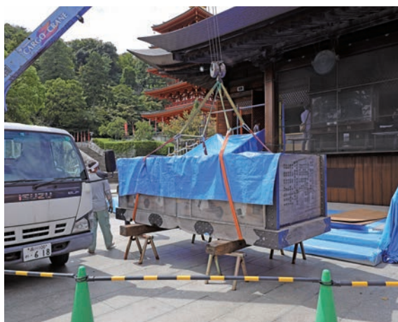
階段工事の為、大賽銭箱を一旦移動 9/17
