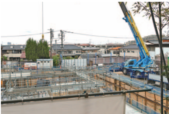
客殿建設工事の進捗状況 4/24
