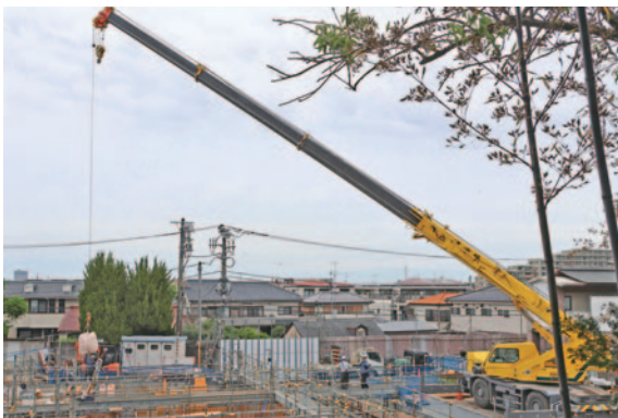
新客殿寺務局「八葉会館」建設状況 6/2
